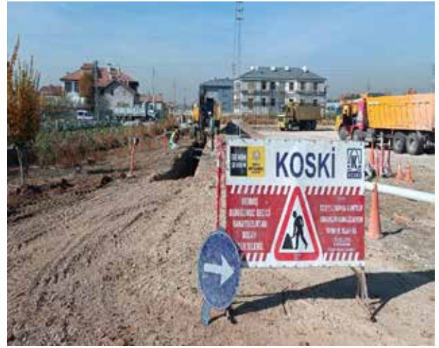
2025 YILI KONYA MUHTELİF SOKAKLAR KANALİZASYON YAPIM VE ISLAHI İŞİ
