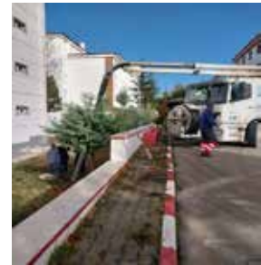
BEYŞEHİR BADEMLİ MH. KANAL ŞEBEKE ARIZASININ GİDERİLMESİ
