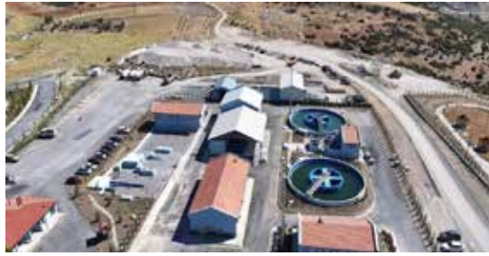
BEYŞEHİR İÇME SUYU ARITMA TESİSİ
