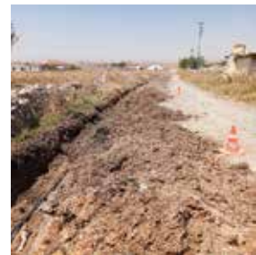
SARAYÖNÜ GÖZLÜ MH. SU ŞEBEKE HATTI ISLAH ÇALIŞMASI
