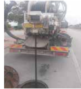
ÇUMRA ÇAYBAŞI MH. KANAL ŞEBEKE ARIZASININ GİDERİLMESİ
