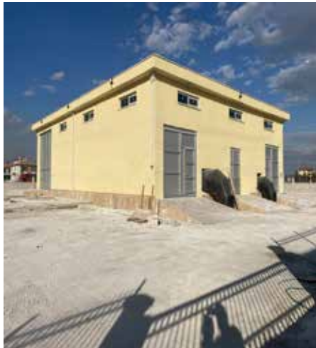
2024 YILI 1'NCİ GRUP SU DEPOLARI YAPIM İŞİ (SU DEPOLARI VE AMBAR YAPIM İŞİ)
