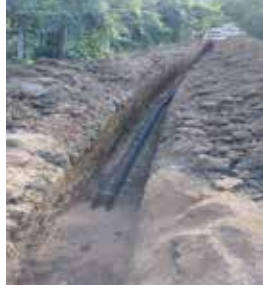
SEYDİŞEHİR DEĞİRMENCI MH. KANALİZASYON ŞEBEKE HATTI YAPIMI
