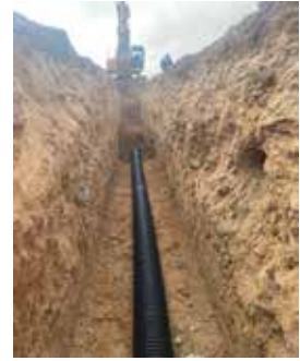
GÜNEYSINIR AĞAÇ MH. KANALİZASYON ŞEBEKE HATTI YAPIMI
