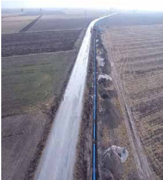
KARAPINAR GRUBU İÇMESUYU İSALE HATTI YAPIM İŞİ (KOSKİ-W2)
