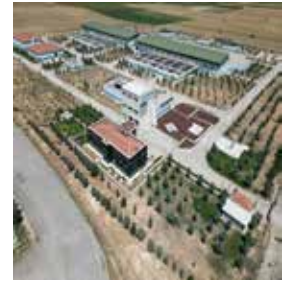
BEYŞEHİR İÇME SUYU ARITMA TESİSİ
