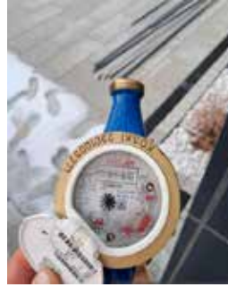
EREĞLİ AYDINLAR MH. PATALAK SAYAÇ DEĞİŞİMİ
