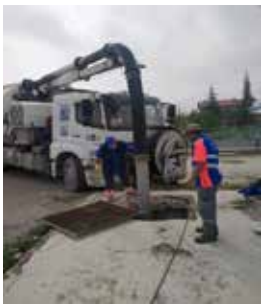
ÇUMRA OKÇU MH. KANAL ŞEBEKE TEMİZLİĞİ
