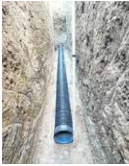
GÜNEYSINIR AĞAÇ MH. KANALİZASYON ŞEBEKE HATTI YAPIMI
