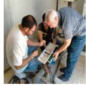
AKŞEHİR SAVAŞ MH. ELEKTRİK ARIZASININ GİDERİLMESİ
