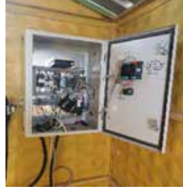
CİHANBEYLİ KARABAĞ MH. ELEKTRİK ARIZASININ GİDERİLMESİ
