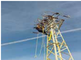
BOZKIR BAĞYURDU MH. ELEKTRİK ARIZASI GİDERİLMESİ ÇALIŞMASI
