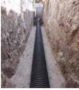
ÇUMRA YENİDOĞAN MH. KANALİZASYON ŞEBEKE HATTI YAPIMI
