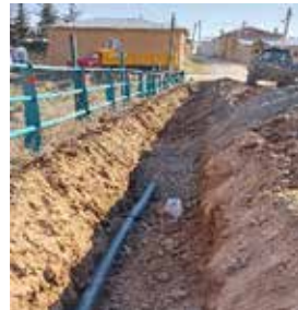
SARAYÖNÜ GÖZLÜ MH. SU ŞEBEKE HATTI ISLAH ÇALIŞMASI
