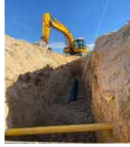
EREĞLİ TOROS MH. KANALİZASYON ŞEBEKE HATTI YAPIMI
