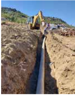
GÜNEYSINIR AĞAÇ MH. KANALİZASYON ŞEBEKE HATTI YAPIMI
