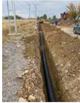
GÜNEYSINIR AĞAÇ MH. KANALİZASYON ŞEBEKE HATTI YAPIMI
