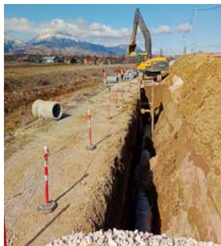
2024 YILI İLÇELER 1. KISIM (DOĞANHİSAR-AKŞEHİR-YUNAK) KANALİZASYON İNŞAATI İŞİ
