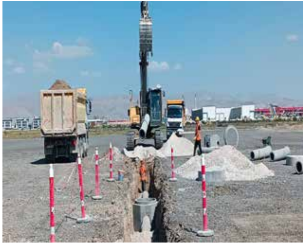
2025 YILI MERKEZ MUHTELİF KANALİZASYON YAPIM VE ISLAHI İŞİ
