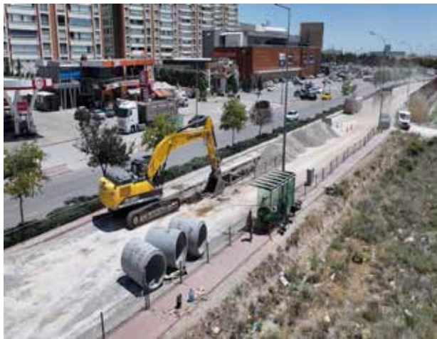
SANCAK MAHALLESİ - BÜSAN SANAYİ ARASI ANA KOLEKTÖR HATTI KANALİZASYON İNŞAATI YAPIM İŞİ
