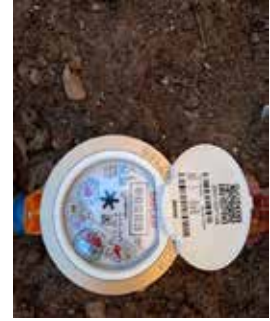
EREĞLİ AYDINLAR MH. PATALAK SAYAÇ DEĞİŞİMİ
