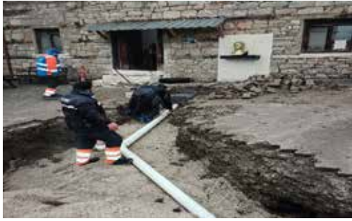
BEYŞEHİR ŞAMLAR MH. KANAL ABONE PARSEL BACA BAĞLANTISI
